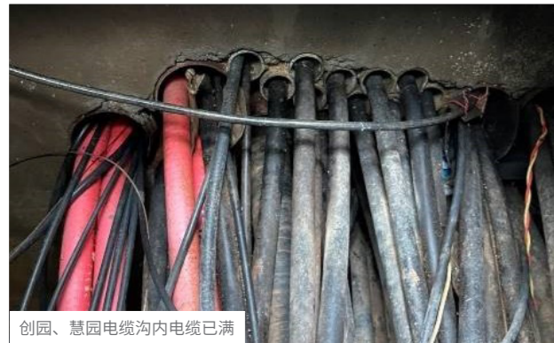
创园、慧园配电房电缆沟入口没有预留空间
