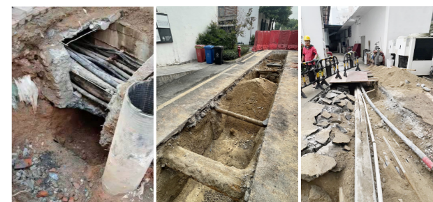
电缆沟开挖后的地下管线情况复杂
