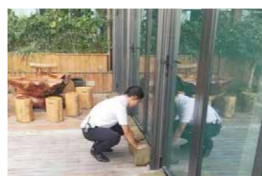
储备应急沙袋、沙条 / 各楼栋电梯口、门边、地库入口提前放置防溢水沙条、沙袋。
